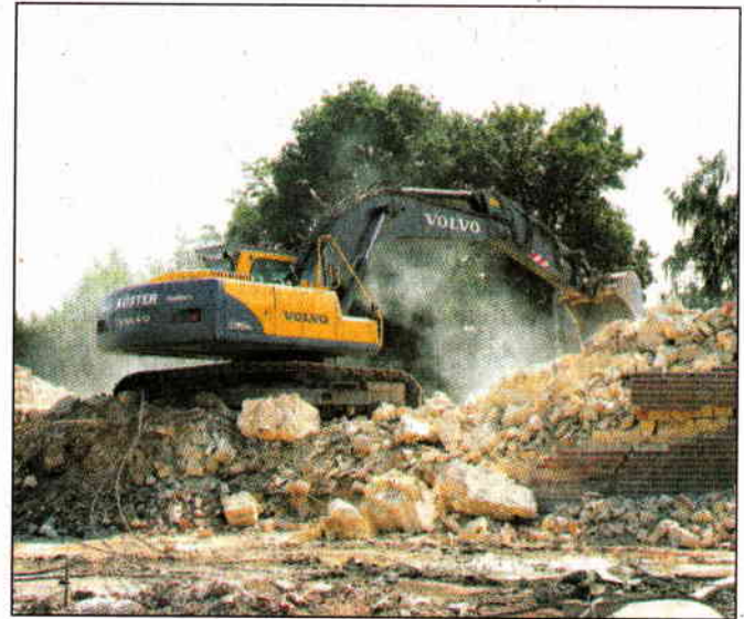
Mit schwerem Gerät beseitigen Arbeiter der Abbruchfirma die Trümmer der abgerissenen Ludgerus-Kirche an der Hafestraße.
