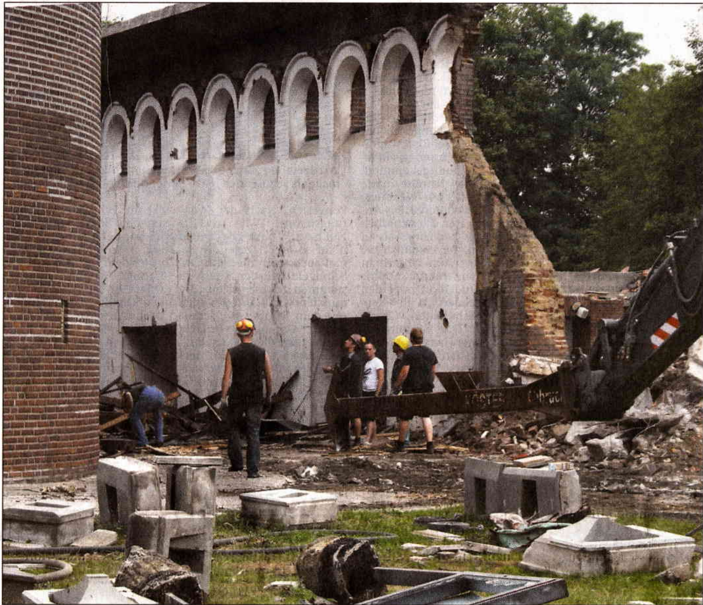
Der Bagger hat ganze Arbeit geleistet: Das Dach der Ludgeruskirche ist binnen kurzer Zeit abgerissen. —FOTO: WESSLING
