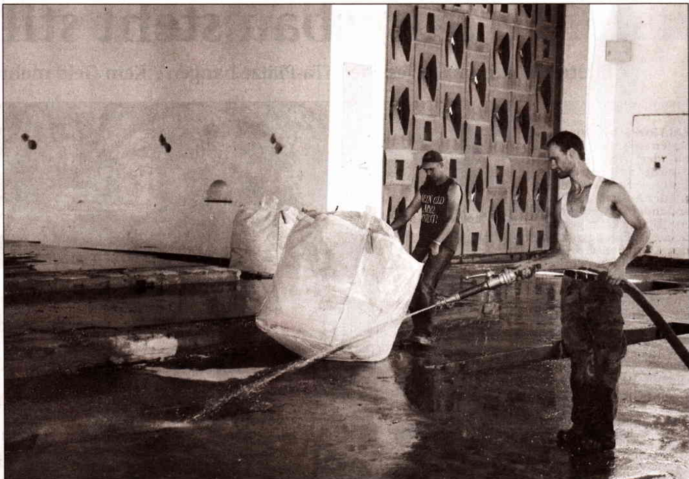
Mitarbeiter von Abrissunternehmen spritzen Wasser ins Kirchenschiff, damit es beim Abriss nicht so staubt. Ab heute wird das Dach abgetragen.
